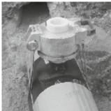
ПЭ 100 SDR 11 Максимальное допустимое рабочее давление 16 бар (вода)/10 бар (газ)
