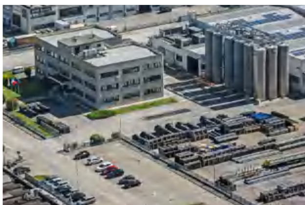
Centro Operativo - Castel Guelfo di Bologna (BO)
