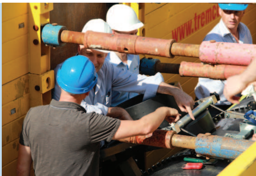
Установка седельного отвода d500 - d2000 мм с выходом d315 - d500 мм
