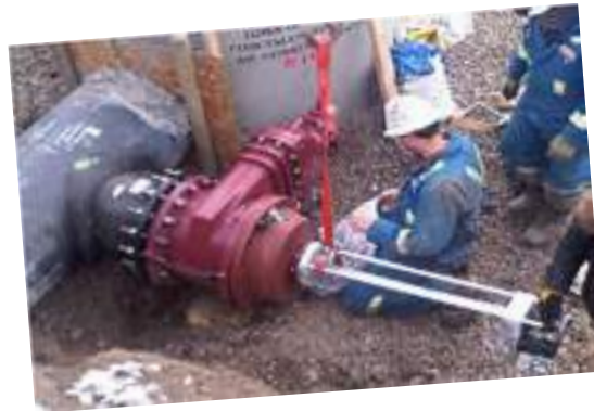
Канада - вредка под давлением отвода 28"x18" 28"x18" IPS EF Semer Canlı Hat Bağlantısı
