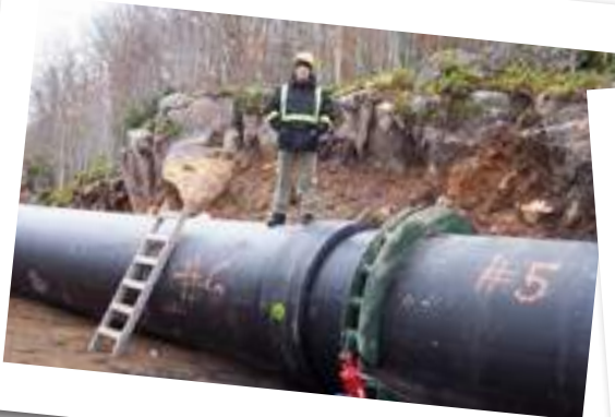
Канада, Халифакс - установка электросварной муфты диаметром 1600 мм - крупнейшей в мире! Canada Halifax - D1600 EF Coupler Application. The Biggest EF Coupler on The World!
