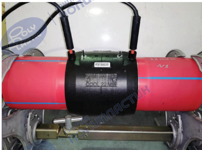
Рисунок 18 – Сварка муфтой с ЗН
