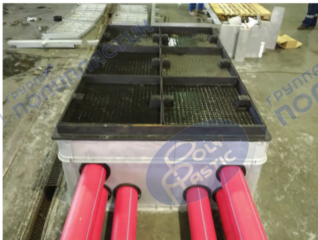
Рисунок 23 – Многоканальное подсоединение труб в МДПС
