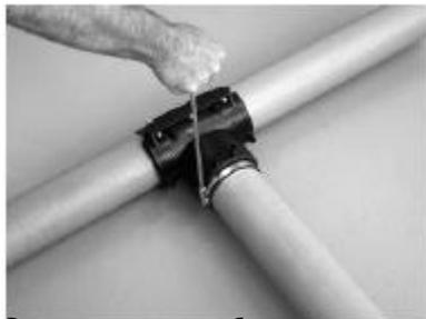
5. Вставить отводную трубу в гнездо седелки до упора, затянуть винты встроенного зажима.
