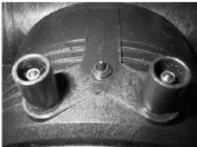
7. По завершении сварки проверить состояние индикаторов на отводном седле и отключить кабели.
