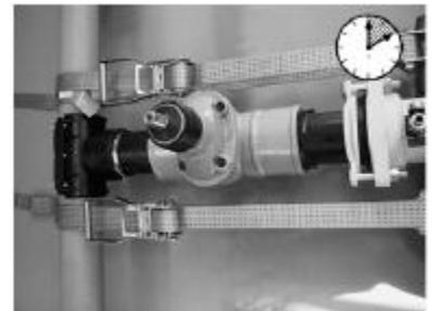
7. Прежде чем приступить к врезке, дождаться окончания минимального периода охлаждения сварного соединения.
