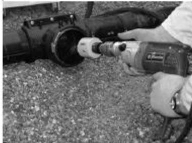
2. В качестве альтернативного варианта допускается использование стандартной дрели с подходящей трубной фрезой (максимально допустимый диаметр 65 или 86 мм).
