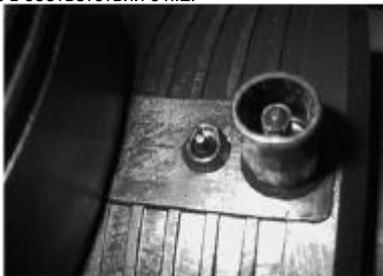
6. По завершении сварки проверить состояние индикаторов на отводной седелке и отключить кабели.
