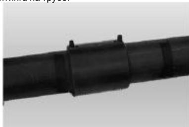
13. По завершении сварки проверить состояние индикаторов на фитинге и показания на дисплее сварочного аппарата, затем отключить кабели.
