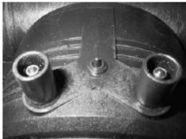
5. По завершении сварки проверить состояние индикаторов на отводной седелке и отключить кабели.
