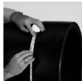
3. Измерить диаметр трубы про помощи гибкой измерительной ленты до зачистки и после нее. Минимально допустимый наружный диаметр составляет:
