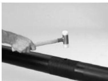
5. С помощью пластмассовой киянки загнать в получившееся отверстие полиэтиленовую ремонтную пробку таким образом, чтобы ее верхний торец касался поверхности трубы.
