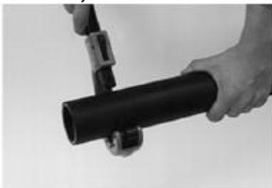
1. Протереть трубу(ы), отрезать под прямым углом и удалить заусенцы.
