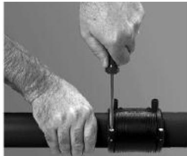
9. Вставить вторую полиэтиленовую трубу в гнездо фитинга до центрального упора или нанесенной отметки.
