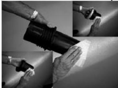
2. Обработать зону сварки трубы чистящей салфеткой и растворителем Tangit PE.
