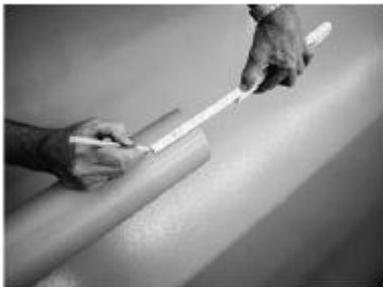
4. Обработать область сварки трубы чистящей салфеткой и растворителем Tangit PE. Отметить глубину вставки в седелку.
