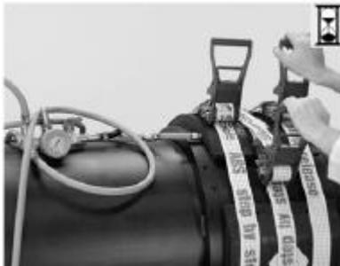
13. Для сварки второй стороны муфты, устанавливать и выравнивать подушки по второму вырезу фитинга допускается не ранее чем через 20 минут после начала периода охлаждения. Снова выполнить центровку фиксирующих ремней вокруг обжимных подушек и произвести аналогичное нагнетание давления (вся операция должна занять не более двух минут). Подключить сварочные кабели к разъемам на второй стороне муфты и выполнить сварку.
