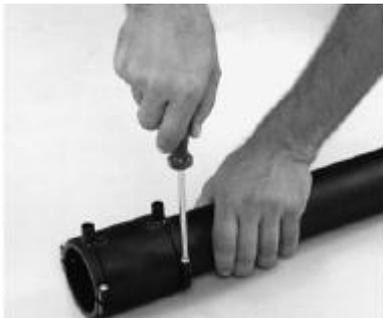
7. Вставить полиэтиленовую трубу в гнездо фитинга до центрального упора или нанесенной отметки.
