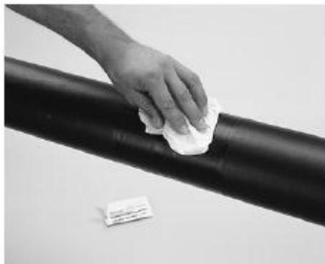
Обезжириванию подвергают только предназначенный для сварки зачищенный участок трубы. При обработке участка большей площади возникает угроза переноса загрязнений на зачищенный участок поверхности.
