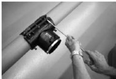
4. Установить отводную седелку на трубу и затянуть крепежные винты. Затягивать винты следует попеременно, до полного устранения зазора и обездвиживания седелки относительно трубы.
