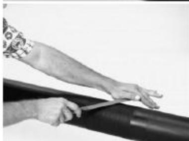
6. С помощью напильника привести пробку в соответствие с профилем трубы.
