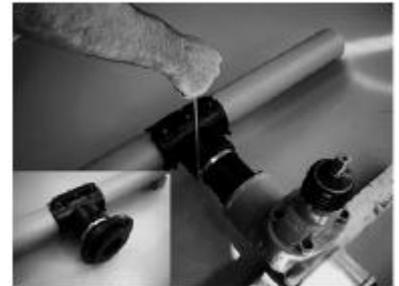
3. Отметить на отводной трубе глубину вставки в седелку.
