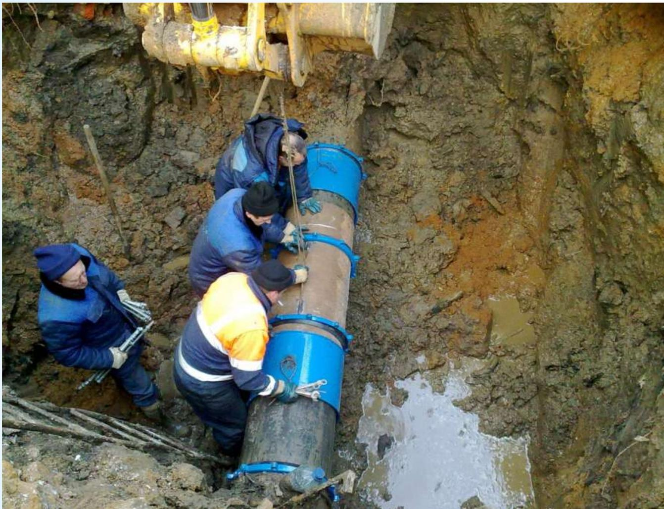
Ремонт чугунной трубы путем вставки отрезка стальной («катушка»).
