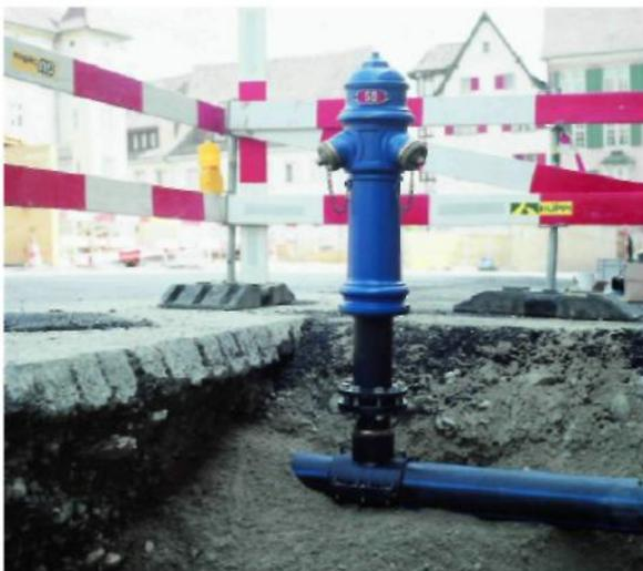
Рис.3: Подключение гидранта с помощью седловой муфты
