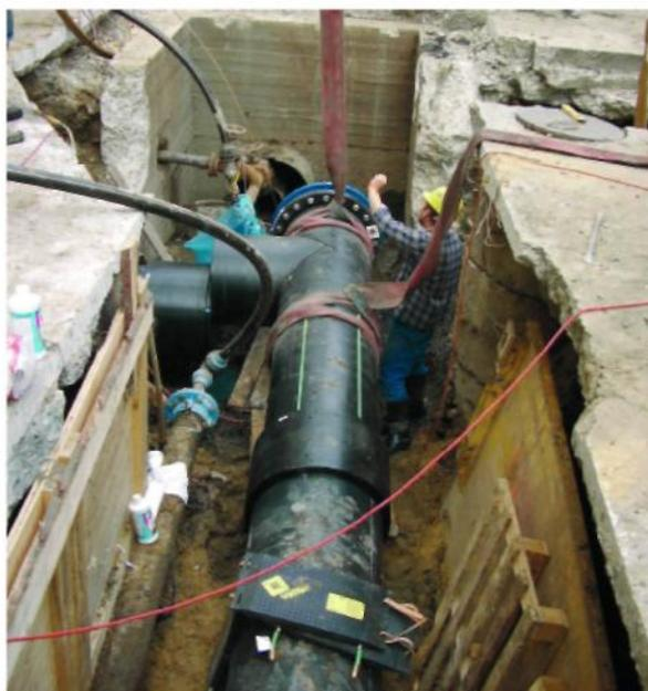
Рис.2: Электромуфтовая сварка для труб диаметром до 630 мм
