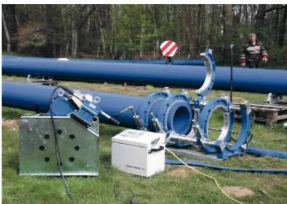
Рис.1: Технология стыковой сварки труб диаметром до 1200 мм.
