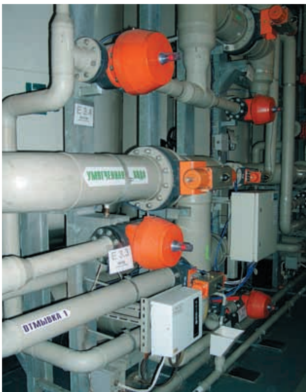
Применение полипропилена на ГЭС-1 (Москва)
