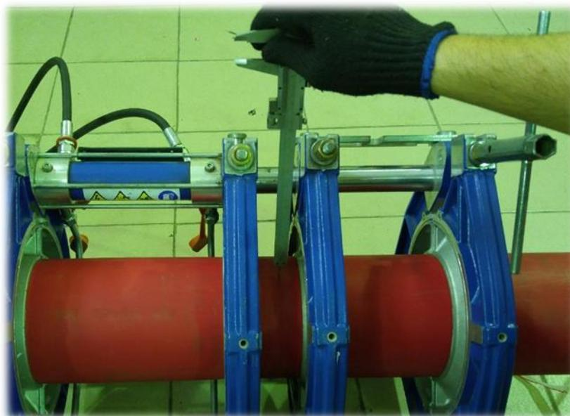
Рисунок 11 — Проверка плотности прилегания свариваемых поверхностей
